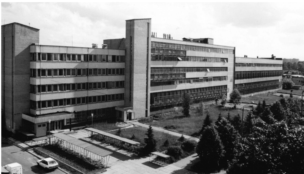
Корпус Опытного производства ОИЯИ
